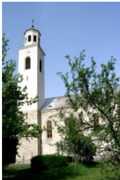
Az 1997-ben újjáépített templomtorony
